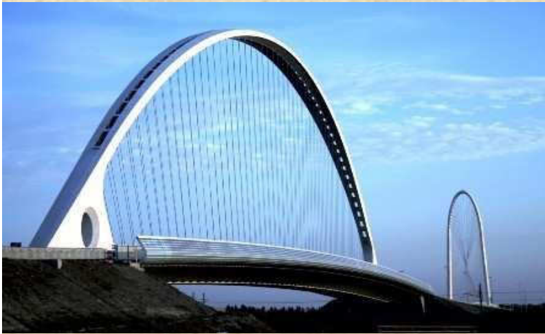
Ponte Calatrava - Reggio Emilia
