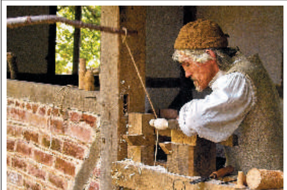
COSTRUZIONE DI PARTI IN LEGNO IN UN'ABITAZIONE.
